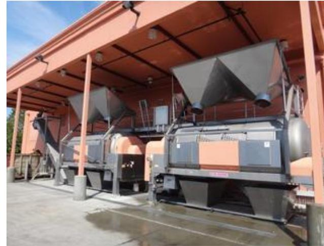
ブドウはこのプラスチックコンテナを使って、フォークリフトでホッパーに投入。赤は、醗酵後のものを、やはりこのコンテナで投入する。
