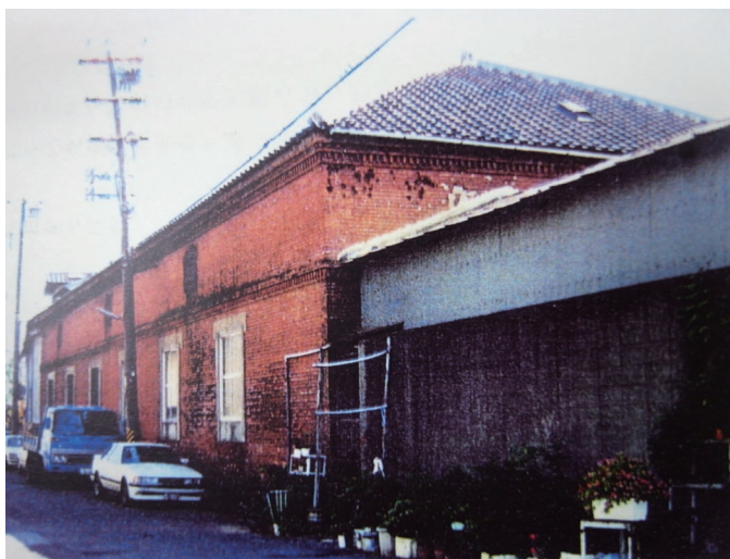
図1 若井酒造煉瓦蔵外観・若井喜一所蔵 明治期に白鹿に次ぐ全国2位の出荷石数だった
